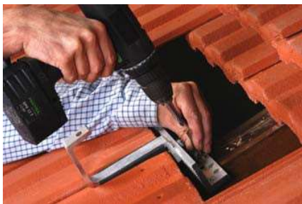
Dachbügelkonsole einrichten und mittels Spax auf Sparren befestigen
