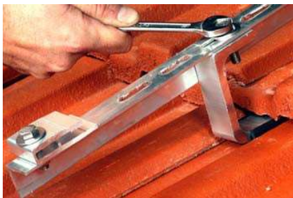
Auflagewinkel mit Dachbügel verschrauben Reihenfolge: Torbandschraube- Aufлагewinkel- Dachbügel - Mutter mit großem Flansch
