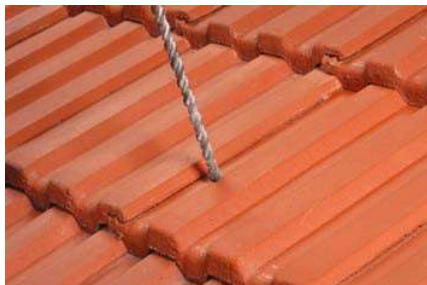
Ziegel bohren - Ø 14 mm
