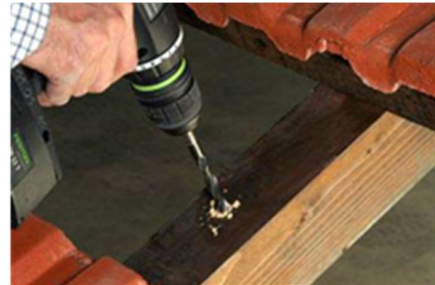
Sparren bohren - Ø 8 mm
