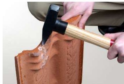
Ziegel einlegen, bei Bedarf bearbeiten
